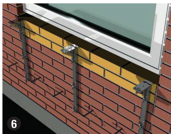
6 Konsolbeslag samles og monteres på gevindstænger. Beslag fastholdes med vingemøtrikker, der håndspændes.
