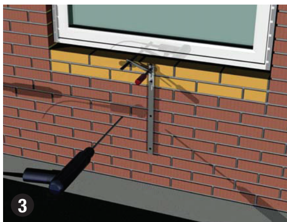
3 U-skinne anvendes som boreskabelon. Hærdeperioden for ny opmuring skal overholdes. Der bores med yderste forsigtighed - slagboring kan komme på tale.
